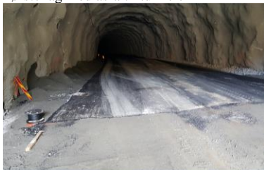
Første lag med asfalt i tunnelen
